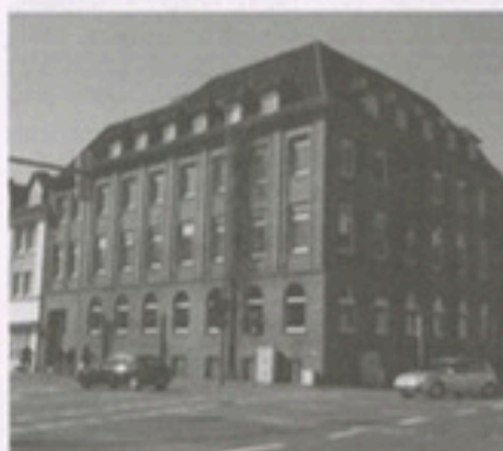
Abb. 1: Blick auf das ehemalige städt. Altenheim von der gegenüberliegenden Kreuzungsecke Kaiserstraße - Rosenstraße (Friedrich-Ebert-Straße) mit dem Rathaus im Hintergrund. Aus: Doris Pieper: Murken fordert „Halbt die Bagger auf“. Ehemaliges Altenheim Kaiserstraße, in: Die Glocke, Gütersloher Ausgabe, 29. März 2011. Foto: Gerrit Dinkels, Die Glocke, 2011.
