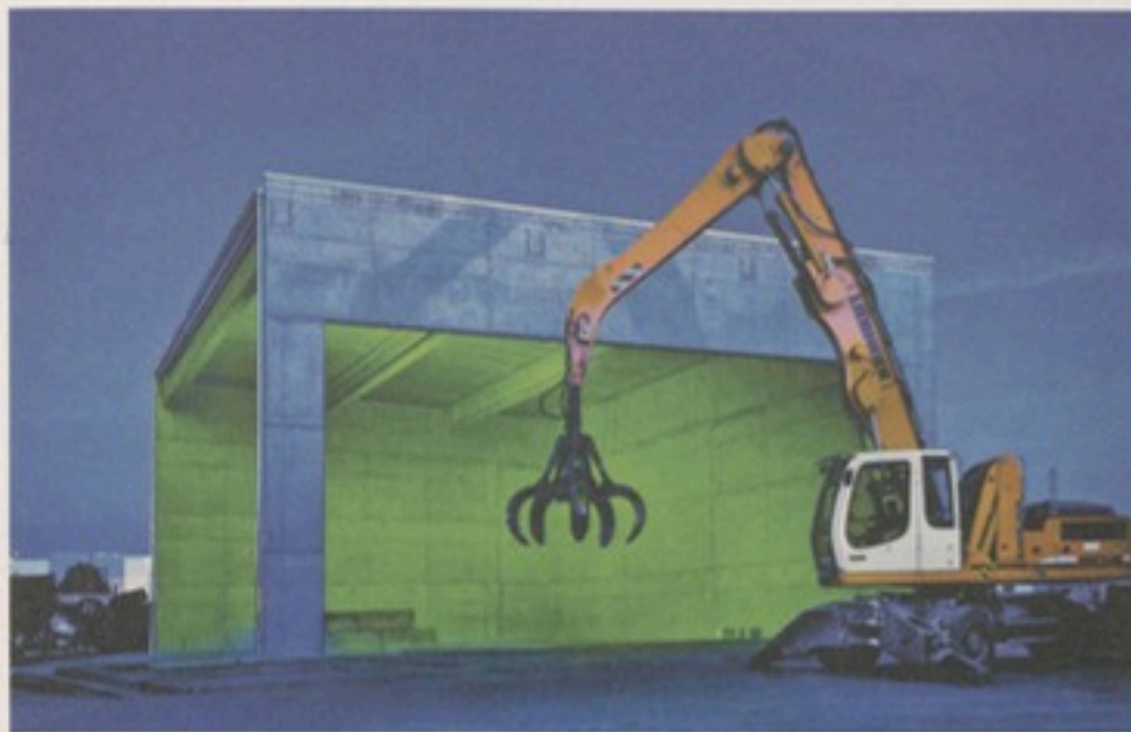
Am 28. Juni 2014 wurde auf dem Firmengelände eine Wetterschutzhalle für ölbehaftete Späne und Stanzabfälle feierlich eingeweiht, firmenintern auch als „Gebr. Diekötter Kolosseum“ bezeichnet. Foto: Gebr. Diekötter Rohstoffe KG
