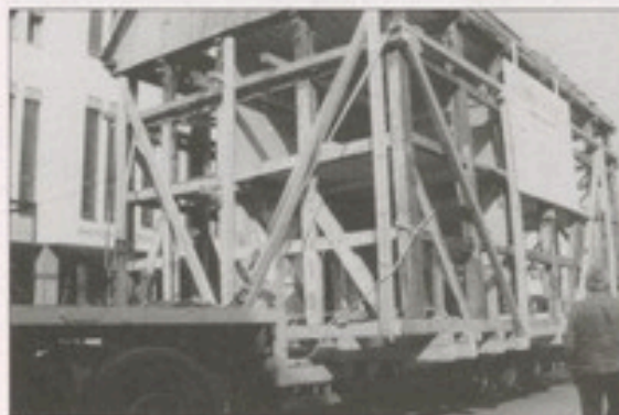
Verladung des „Mauerblümchens“ auf einen Tieflader an der Mauerstraße 11.
