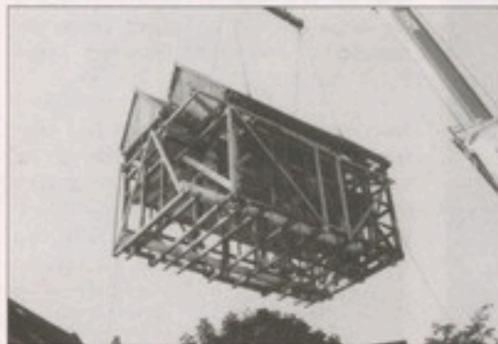
Ein Haus schwebt durch die Luft. Fest verpackt in einem Gestell aus Bohlen und Tauen.
