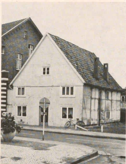
Die Stadtkernsanierung in Rheda forderte bereits das 25. „Opfer“: Das Haus Reckhaus an der Kirchstraße, neben der Bäckerei Mönchmeier und unweit der Andreaskirche gelegen, verfiel der Spitzhacke.
