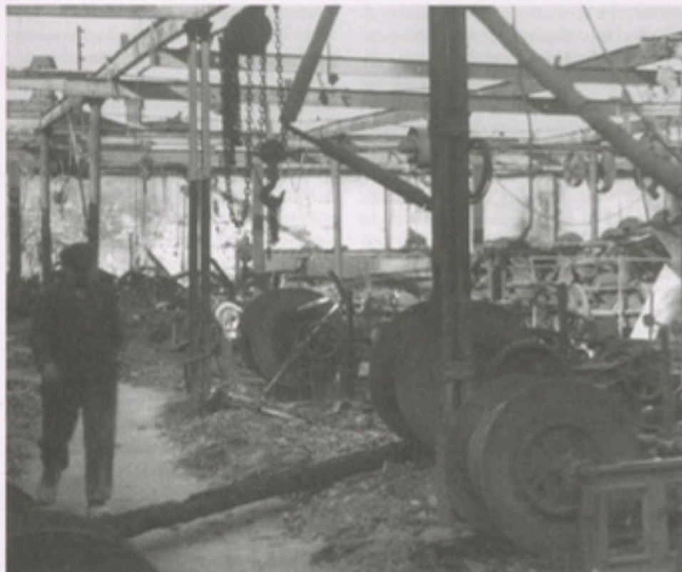
Schwere Schäden erlitten auch die Gütersloher Industriebetriebe. Unser Foto zeigt die Firma Draht-Wolf.
