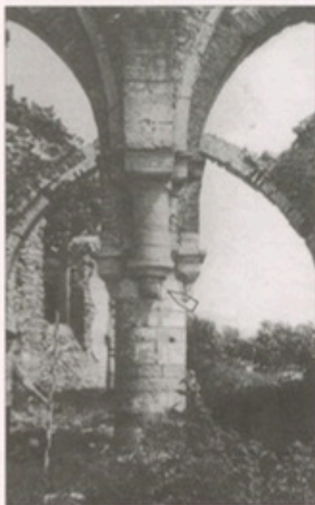
Chorbogensäule in Uexküll. Das Kapitell gleicht in Form und Funktion den Gewölbekonsolen im Schiff der Marienfelder Klosterkirche. Der Pfeil bezeichnet die Stelle an der die Rose angebracht war. Foto: Uexküll, Kirchenführer, 2001.
