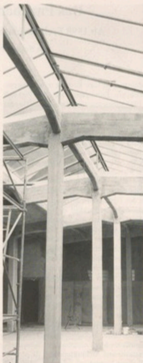
Wenn's fertig ist, könnte mal ein Ausstellungsraum draus werden: Schendachkonstruktion im Zentrum des ehemaligen Parkbad-Umkleidegebäudes.
