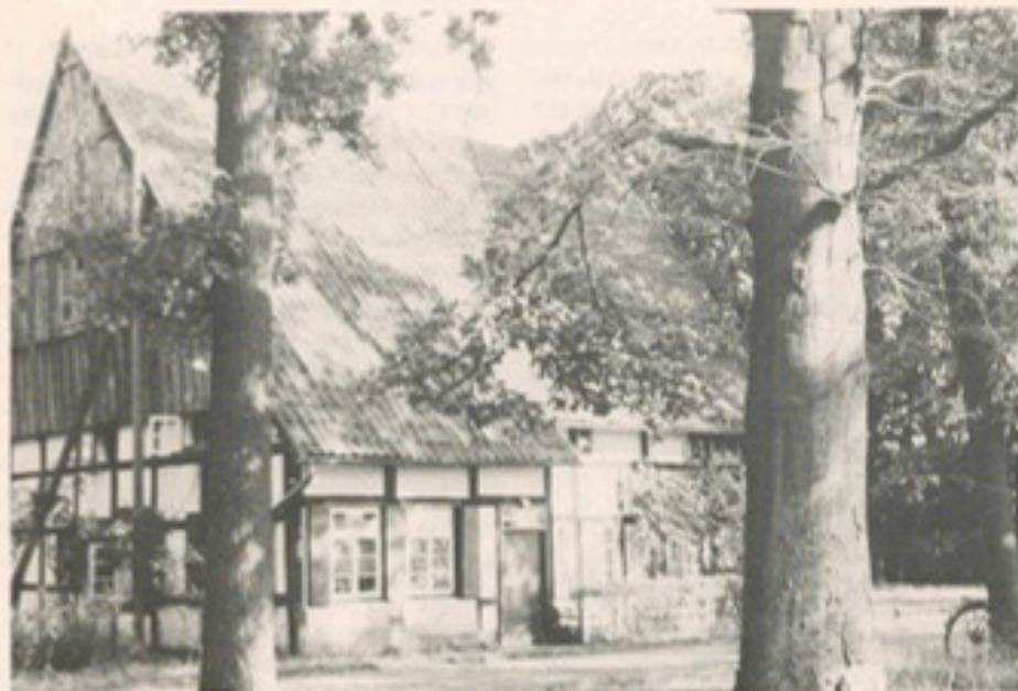
Bild 1: In diesem Heuerlingshaus des Meierhofes Witthof in Pavenstädt wurde eine Schule eingerichtet.
