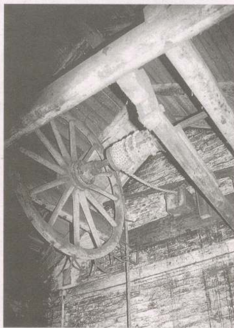
Die Rolle. Hier ein 120 cm großes Speichenrad. Eine Rille in der Felge dient mit dem gelochten Brett der Seilführung.
