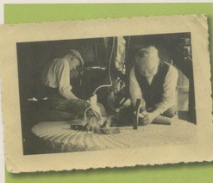
DIE MÜLLER UND MÜHLENBESITZER PAUL EIKELMANN (LINKS) UND THEODOR EIKELMANN (RECHTS) BEIM SCHARFEN DER MÜHLSTEINE, UM 1940 Foto: Privatbesitz Maria Eikelmann
