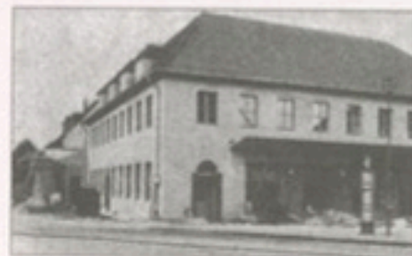
Das Bild wurde kurz vor Fertigstellung des ersten Bauabschnitts gemacht. Es zeigt die Lücke in der Mitte des Gebäudes. Hier fehlt noch die Empfangshalle.
