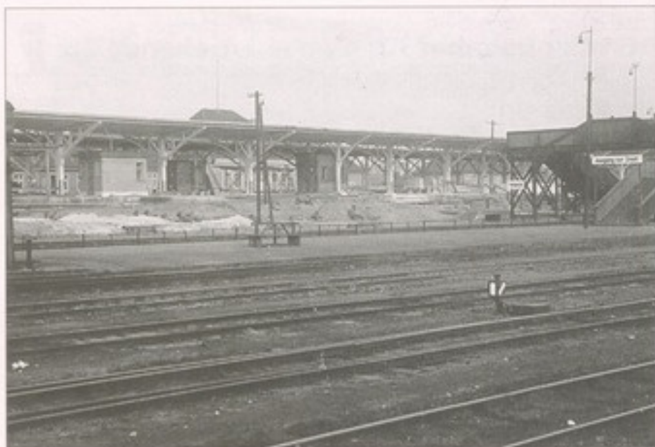
Zwei Jahre lang mußten die Reisenden über eine Holzbrücke (r.) gehen, bis die neuen Gleise fertig waren.
