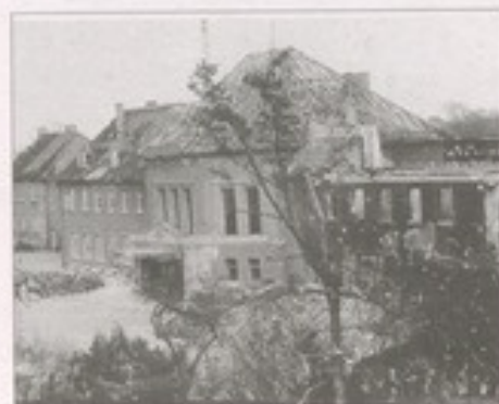
Bomben auf Gütersloh: Noch kurz vor Kriegsende wurde das Empfangsgebäude der Bahn schwer beschädigt.
