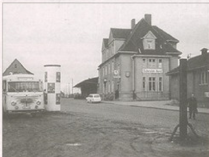
Vor dem Bau der Unterführung an der Friedrich-Ebert-Straße: die Straßenseite des Bahnhof Gütersloh-Nord im Jahr 1962.
