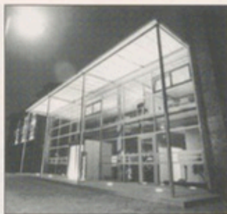
Alt und neu architektonisch reizvoll verbunden: Eingang zur „Medienfabrik“. Bild: Jörg Säger
